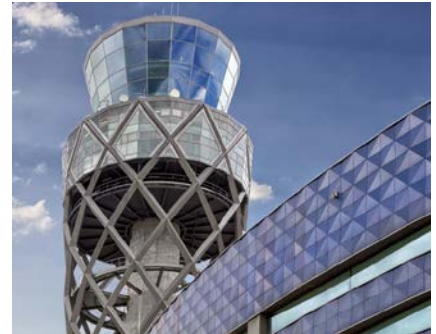
Aeropuerto Torre control Bogotá (Colombia)
